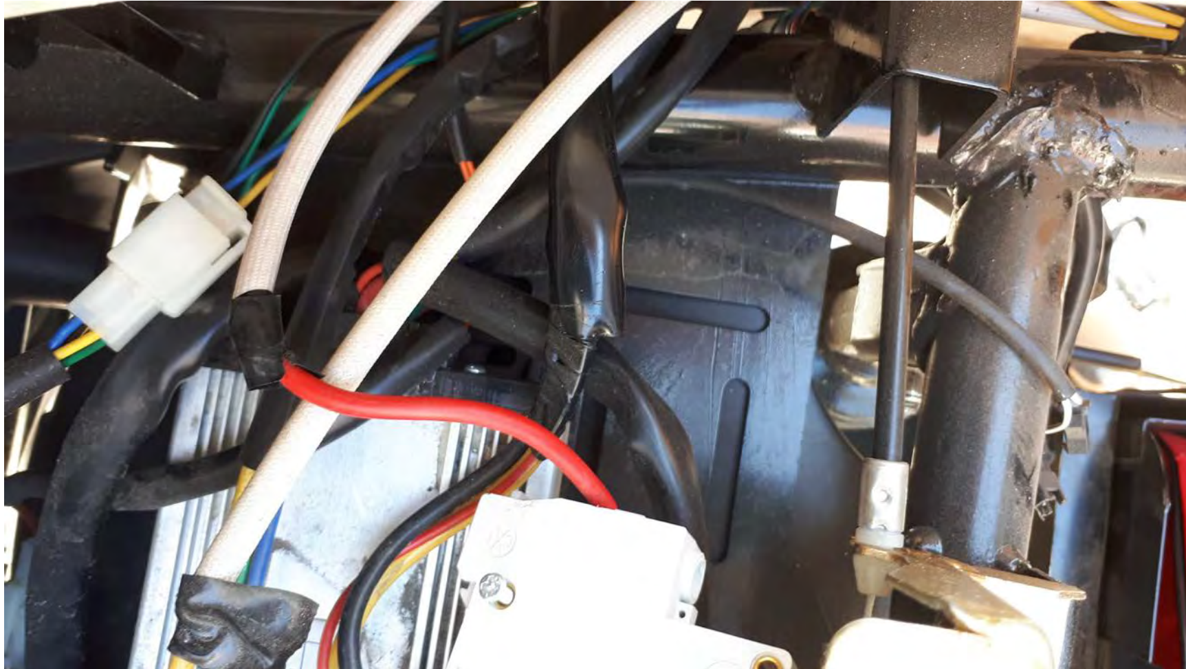
Blick zum Controller nachdem die Sitzbank demontiert wurde.
